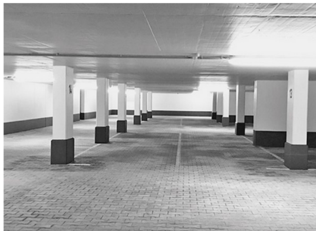
Die Tiefgarage nach Fertigstellung der Sanierung.
