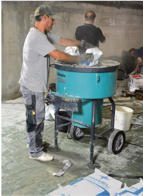
Befüllen des Kompaktmischers TMX 1000.
